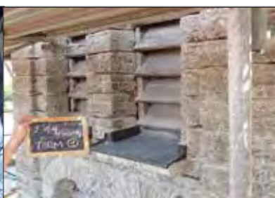
Sanierung Tuff, Bleiabdeckung neu
