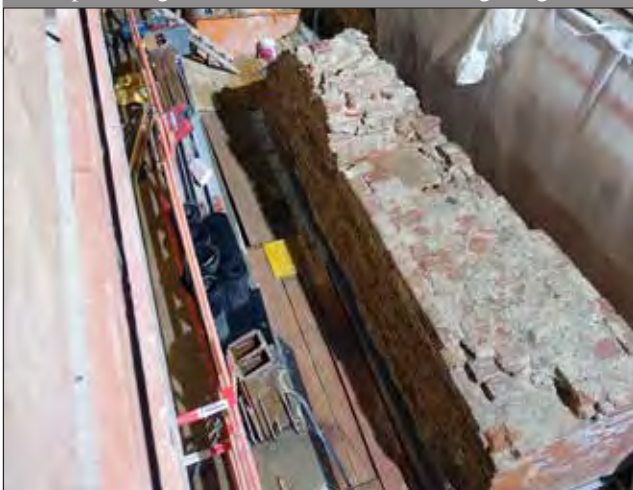
wiederversetzter Mauerabschnitt am originalen Standort
