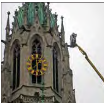
Befahrung mit dem Hubsteiger
