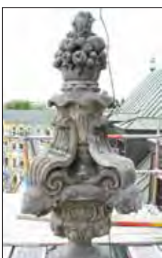
Vase wird mittels Gewindestange durch Anpressdruck verspannt
