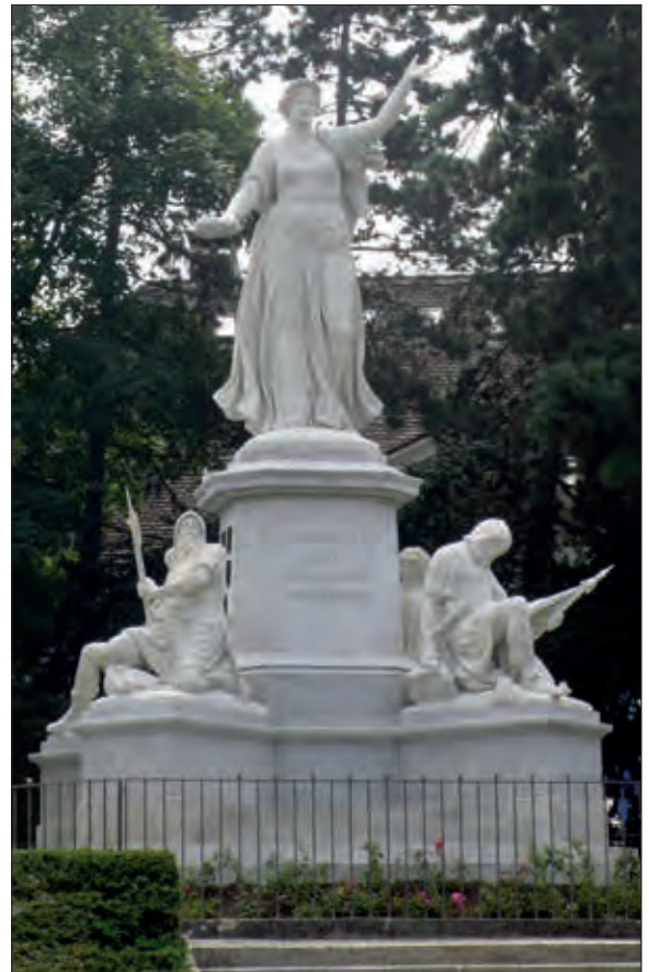
Basel (CH), St. Jakobsdenkmal, 19. Jh. Konservierung, Oberflächenbehandlung Auftraggeber | Beteiligte: Bau- und Verkehrsdepartement des Kantons Basel-Stadt, Hochbau- und Planungsamt | Münsterbauhütte | Kantonale Denkmalpflege Basel-Stadt
