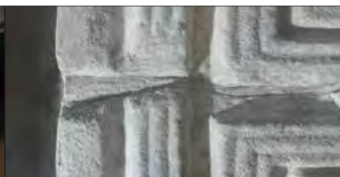
Detail Ergänzung Bruchkante
