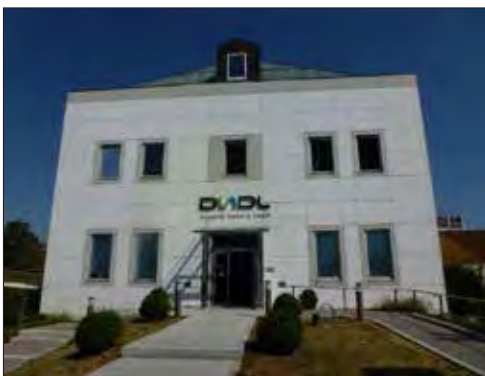
Vorgesetzte Fassade vor Sanierungsbeginn
