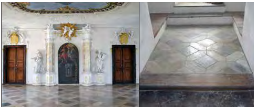
Ottobeuren (D), Klosteranlage, 18. Jh., Sanierung Solnhofener Rosenspitzbelag Auftraggeber | Beteiligte: Staatliches Bauamt Kempten | Mitternacht Ingenieure | BLfD
