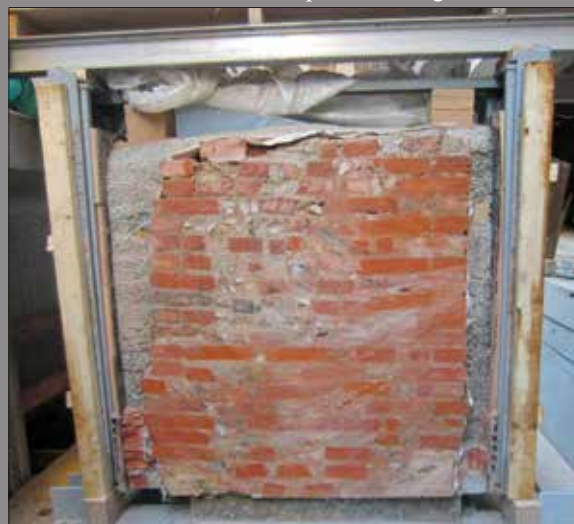
Mauer mit Transportsicherung - durch Seilsägen erzeugter Querschnitt: historischer Aufbau wird erkennbar
