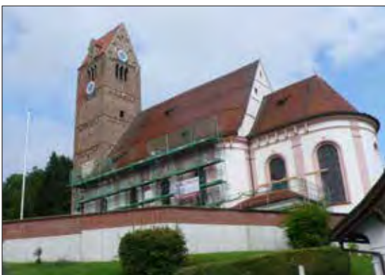
Pfarrkirche Leeder, Turmsanierung
