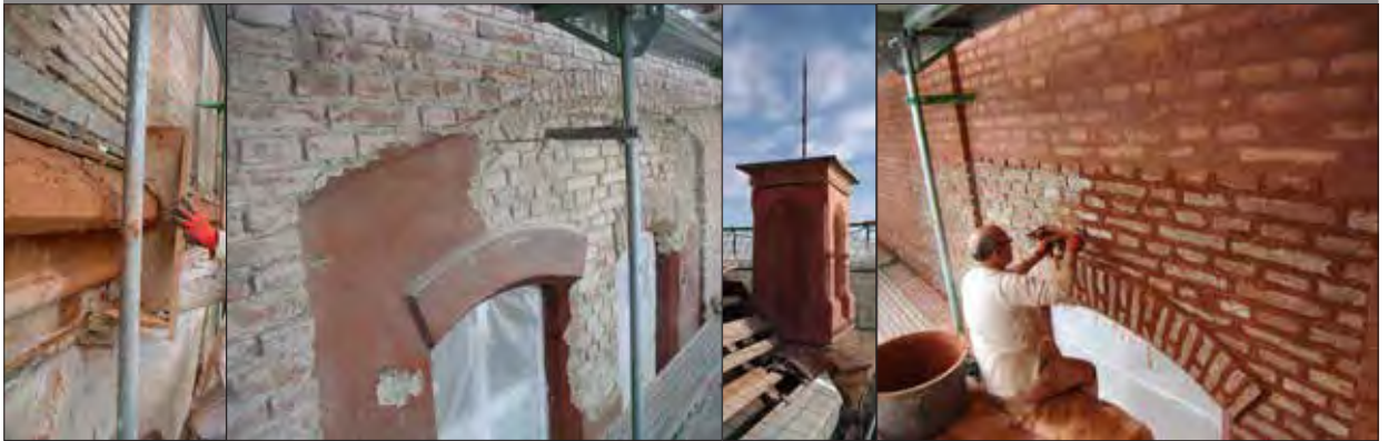
Gesimsrekonstr. Zustand Fassade vor der Sanierung Türmchen (Replikat) Fugenverbandelung
