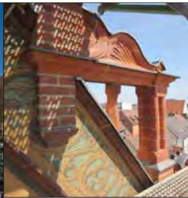
Fertig sanierte Zinne
