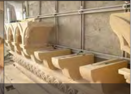
Befestigung der neuen Terrakotten
