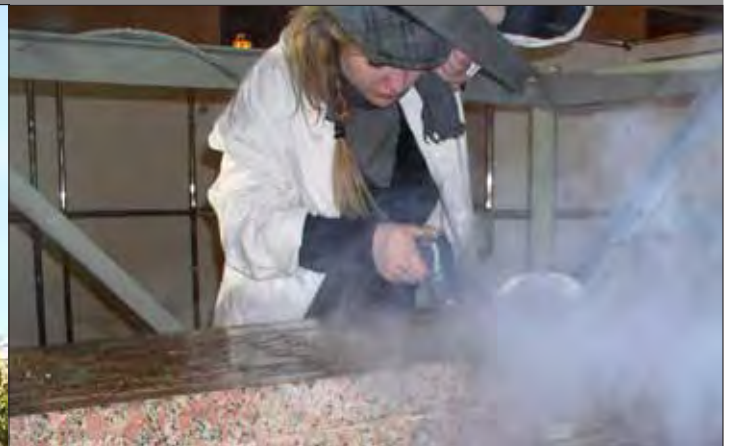
Reinigung der Oberfläche mit Mikrodampf
