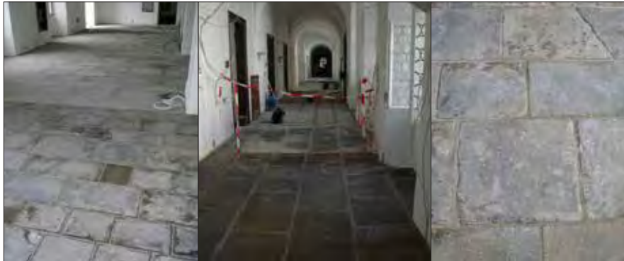
Füssen (D), Kloster St. Mang, frühes 18. Jh., Sanierung Sandsteinböden Auftraggeber | Beteiligte: Bauamt Stadt Füssen | BLfD
