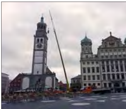
Befahrung mit dem Hubsteiger
