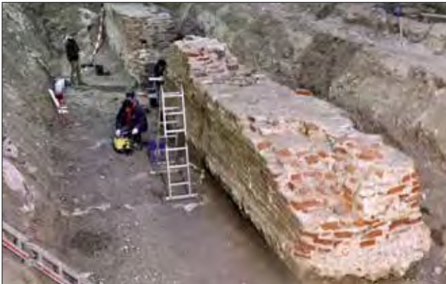
bei Baumaßnahme freigelegte Stadtmauerabschnitte
