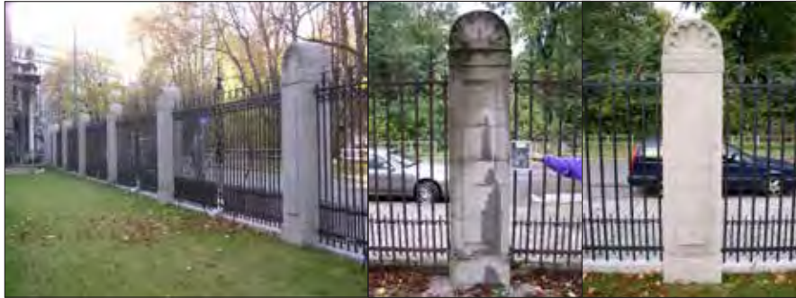
Ausschnitt der Zaunanlage nach der Sanierung (130 m Zaunlänge)
