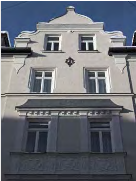
München (D), Belfortstr. 5 Wohnhaus, um 1900 - Begutachtung, Sanierung der Putz- /Stuckfassade Auftraggeber | Beteiligte: WEG Belfortstr. 5 | Baye- risches Landesamt für Denkmalpflege | Untere Denkmalschutz-Behörde Stadt München
