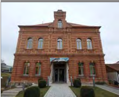
Südfassade mit rekonstruierter hist. Gaube
