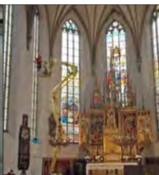
Befahrung mit dem Hubsteiger
