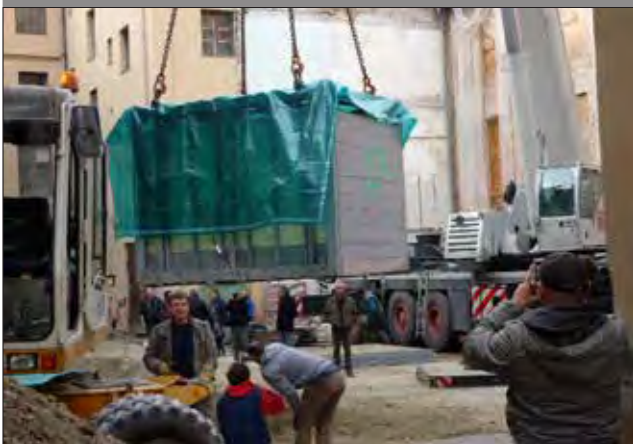
Transport der geteilten Mauer zur Zwischenlagerung
