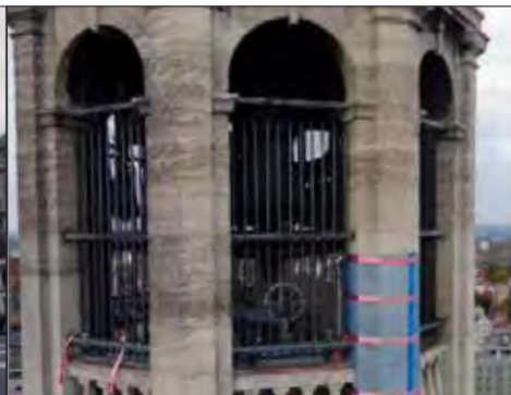
Sicherung des Pfeilers durch Spanngurte und Netze
