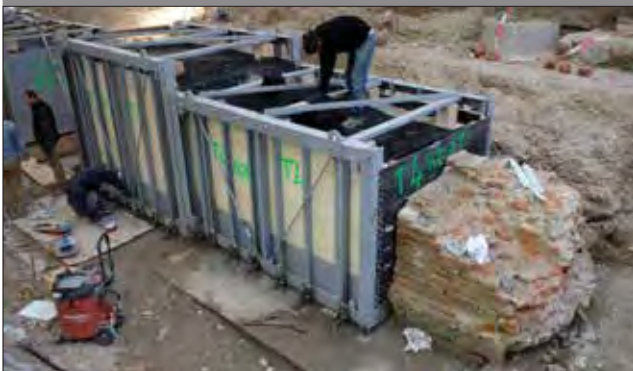
Aufbau mehrerer Transportbehälter
