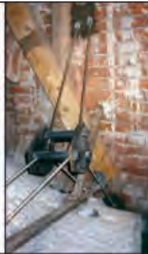
Neue innenliegende Edelstahlkonstr. sichert die einsturzgefährdeten Gewölbe durch eine Umlagerung der Zug- und Druckkräfte
