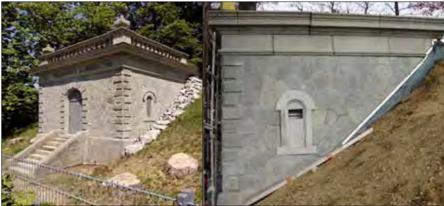
Polygonalmauerwerk nach der Sanierung
