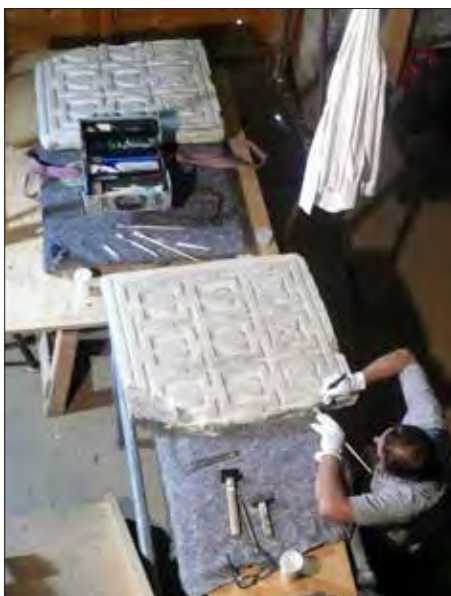
Bearbeitung der Bruchkante
