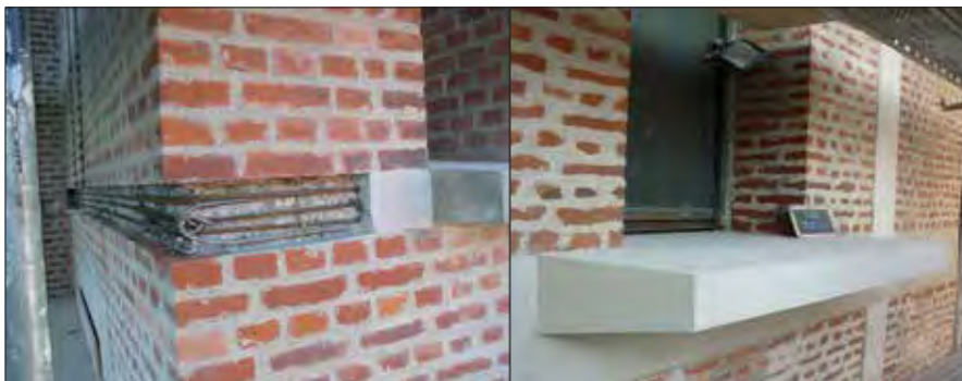
Verstärkung der vorhandenen Bewehrung am Ringanker
