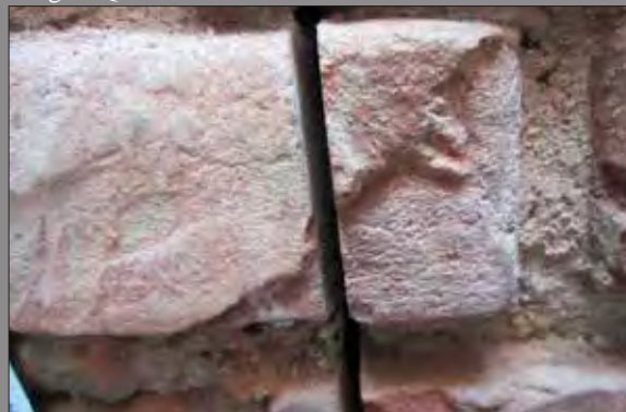
Schnittstelle zwischen zwei neuversetzten Abschnitten
