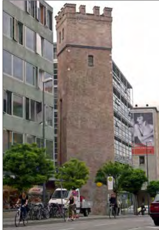
München (D), Löwenturm, 12. - 15. Jh. Generalsanierung Auftraggeber | Beteiligte: Stadt München (Baureferat) | Bayerisches Landesamt für Denkmalpflege | Akademie für Handwerksfortbildung, Thierhaupten | Architekturbüro Kunz
