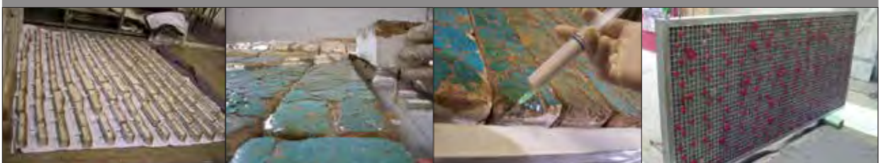
Reversible Montage: die Ziegel sind einzeln mit Schrauben befestigt und können bei Bedarf demontiert werden
