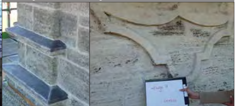
Sanierung Tuff, Bleiabdeckung neu
